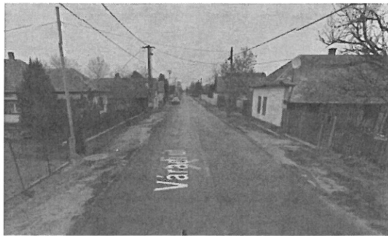
10. kép. Épület miatti szűkület a 764-773 szelvények között
