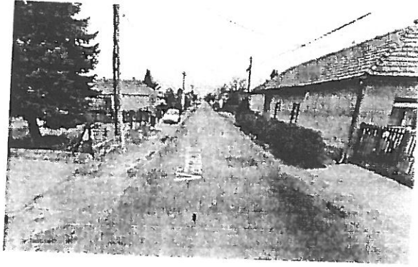
10. kép. Épület miatti szűkület 705 és 725 között
