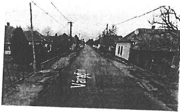
11. kép. Épület miatti szűkület a 764-773 szelvények között
