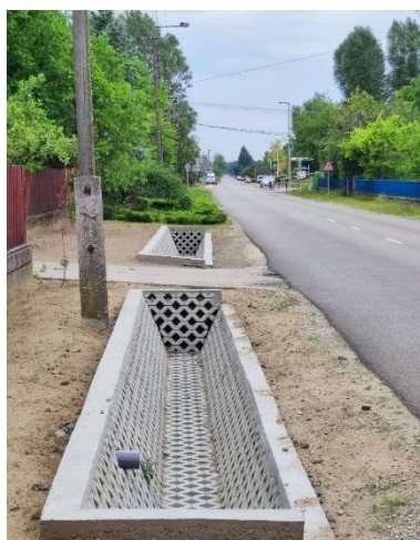
a Köztársaság út menti felújított nyílt földárók
