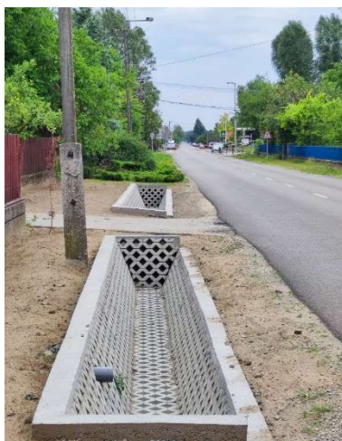
a Köztársaság út menti felújított nyílt földárók
