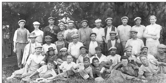
A brigád ebédidőt tart, miközben „lekvárgyárat” építenek a „Berci telepén” (1930-as évek)
